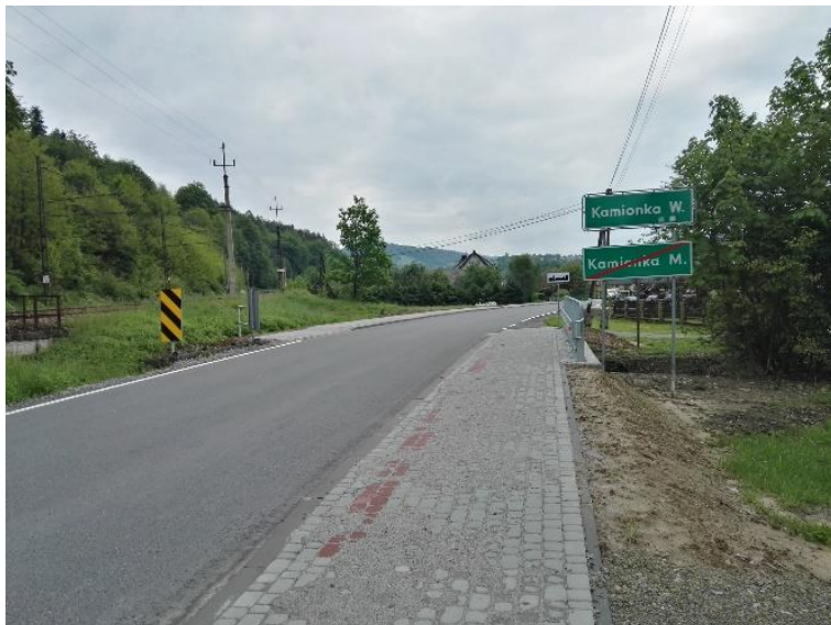
Rysunek 11. Wybrane zadania zrealizowane w ramach wydatków inwestycyjnych Powiatu Nowosądeckiego przez Powiatowy Zarząd Dróg w Nowym Sączu w 2019 roku
