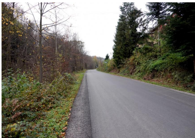
Rysunek 14. Wybrane zadania zrealizowane w ramach remontów dróg powiatowych w 2020 roku
