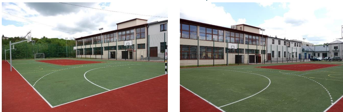
Rysunek 7. Przebudowa boiska sportowego przy Zespole Szkół Zawodowych im. Stanisława Staszica w Grybowie
