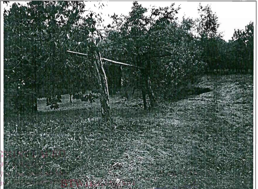
Świeża skarpa główna osuwiska
