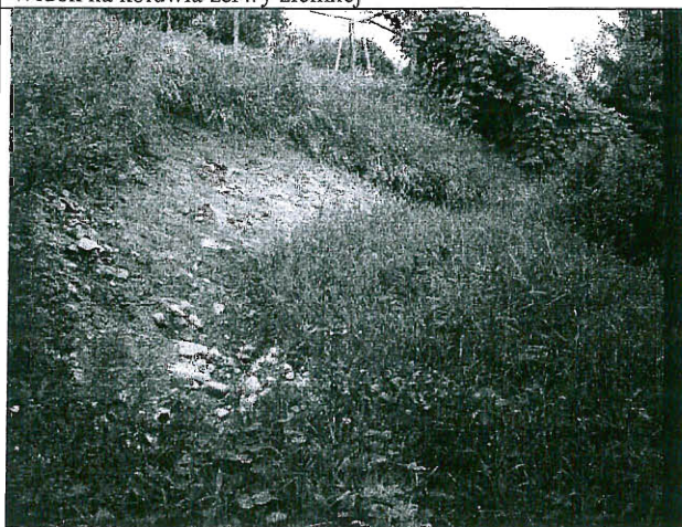
Widok na skarpe zerwy ziemnej nad budynkiem
