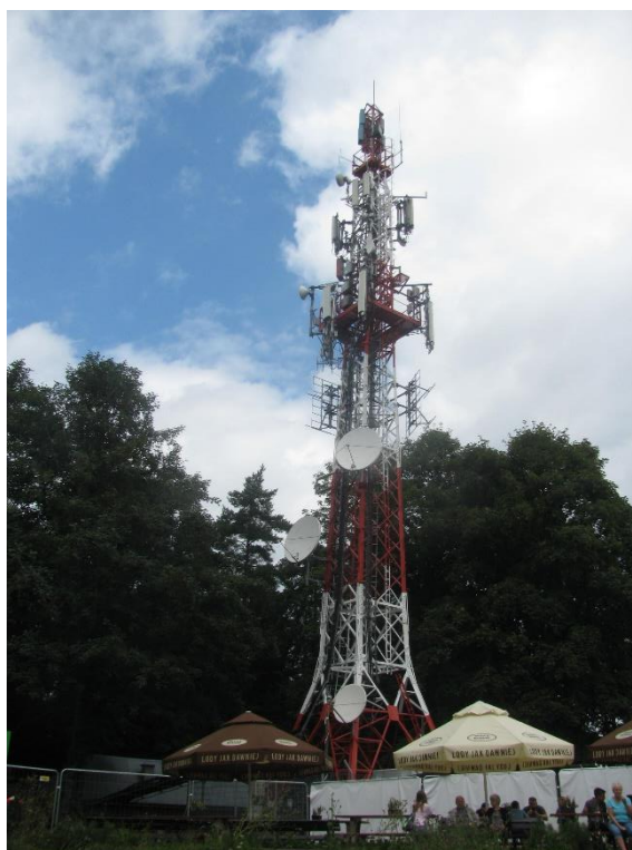
Zał. nr 1: Widok ogólny instalacji radiokomunikacyjnej.
