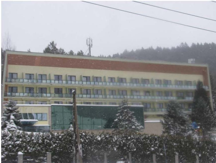
Zał. nr 1: Widok ogólny instalacji radiokomunikacyjnej.
