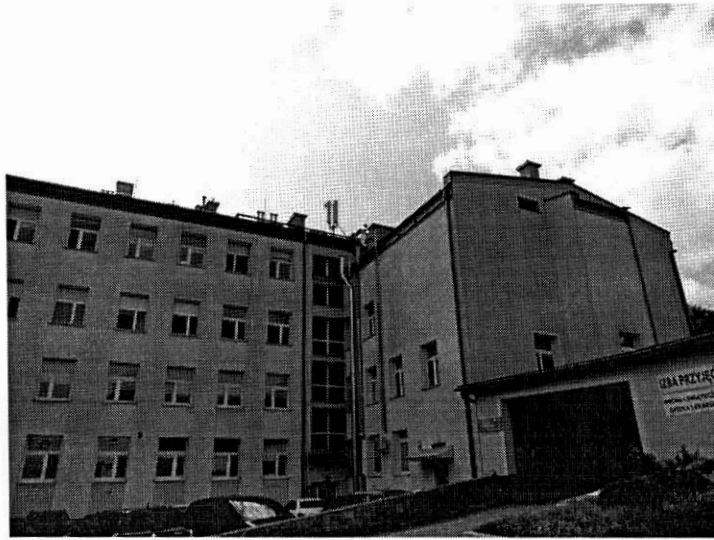
Zał. nr 1: Widok ogólny instalacji radiokomunikacyjnej.
