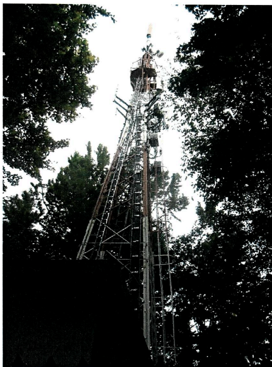
Zał. nr 1: Widok ogólny instalacji radiokomunikacyjnej.
