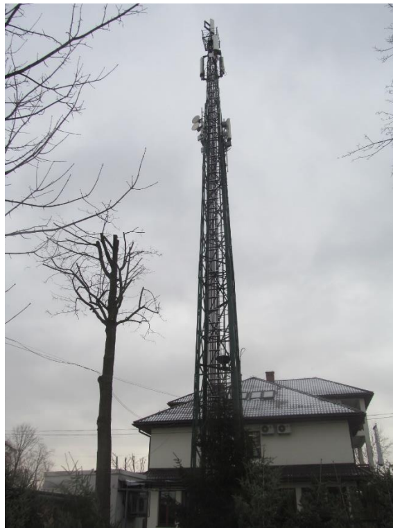
Zał. nr 1: Widok ogólny instalacji radiokomunikacyjnej.
