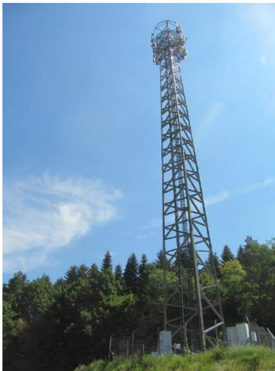
Zał. nr 1: Widok ogólny instalacji radiokomunikacyjnej.
