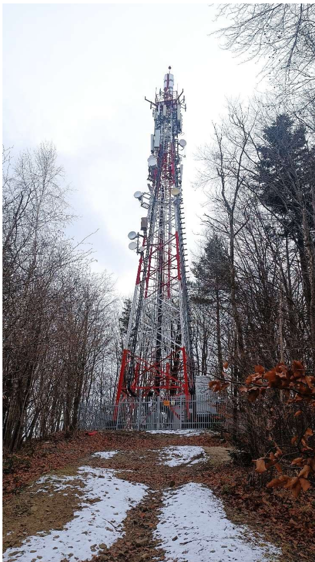
Zdjęcie 1 Badany obiekt
