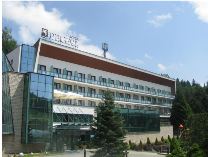
Zał. nr 1: Widok ogólny instalacji radiokomunikacyjnej.
