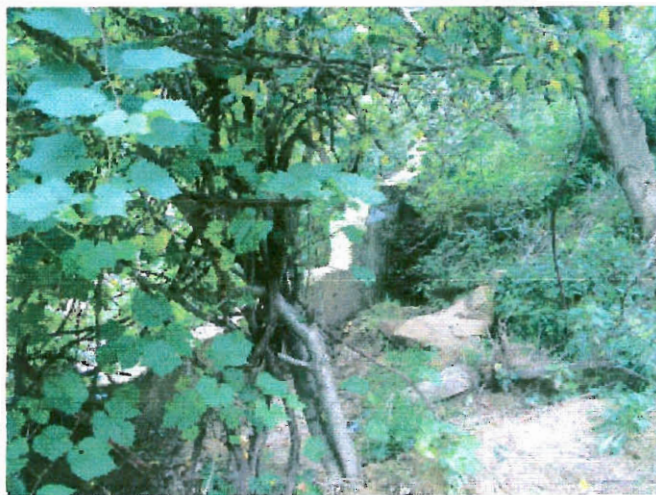
mur oporowy zabezpieczający budynek mieszkalny
