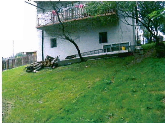
zagrożony budynek mieszkalny
