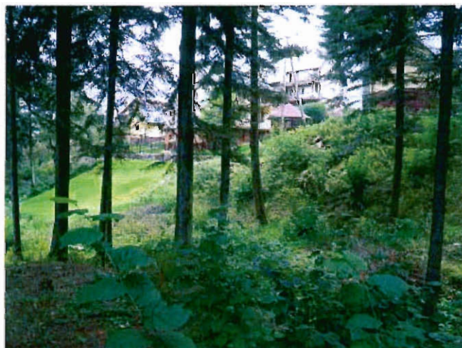
skarpa z osuwiskiem aktywnym i sąsiednim zabezpieczonym
