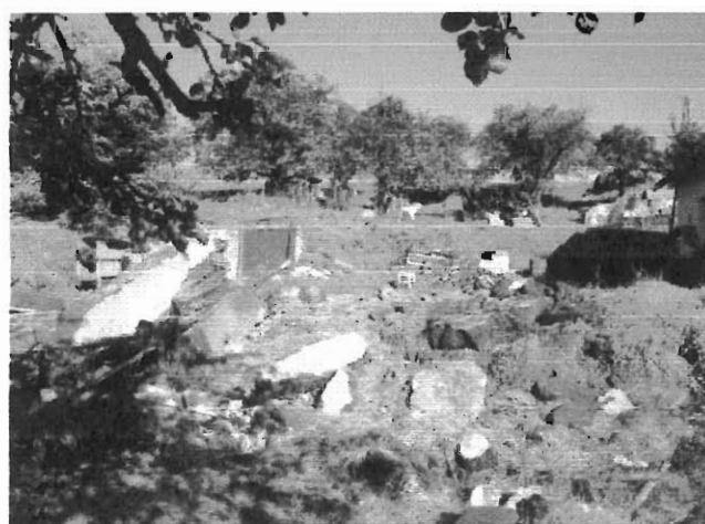
Miejsce po zniszczonym budynku gospodarczym
