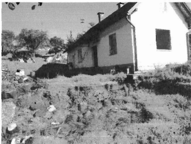
Skarpa poniżej budynku mieszkalnego
