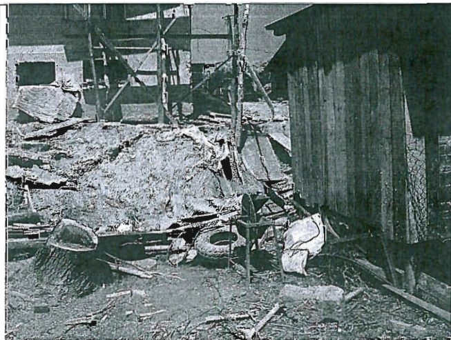
Skarpa główna osuwiska w rejonie zabudowań
