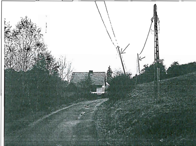
Uszkodzona droga, linia energetyczna i telefoniczna
