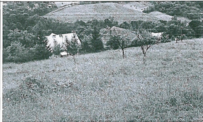
Uszkodzone budynki mieszkalne (Lipie 86 i Jelna 88) i gospodarczy (Jelna 88)
