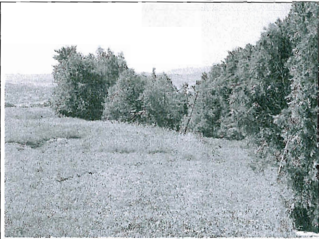
Osuwisko poniżej zabudowań mieszkalnych, uszkodzony słup elektryczny
